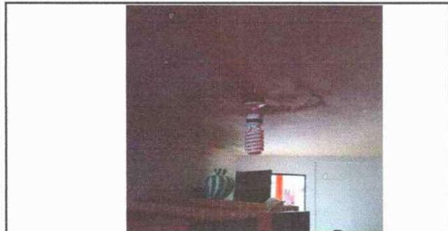
Foto 5: SE OBSERVA LA PRESENCIA DE HUMEDAD AVANZADA EN LA TERRAZA DEL AREA DE SANITARIOS
