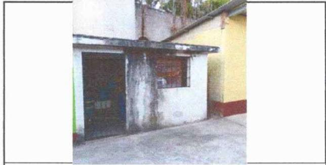
Foto 8: DETERIORO DE PARED Y TERRAZA CON FILTRACIÓN DE AGUA.
