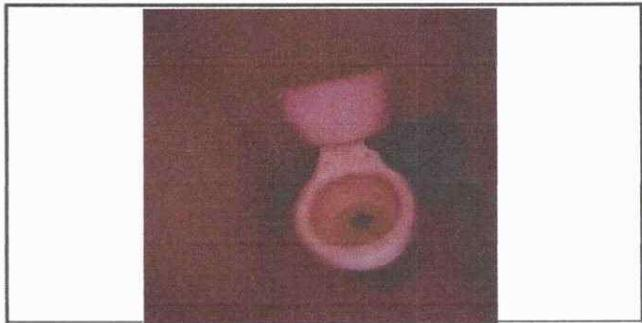
Foto 2: SE OBSERVA VARIOS SANITARIOS CON TAPA DE DEPOSITO QUEBRADAS
