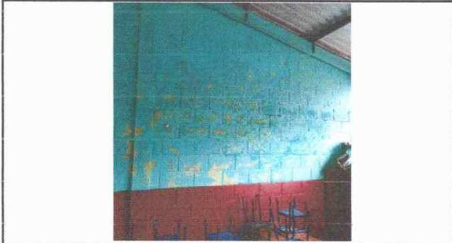
Foto 13: SE OBSERVA LA PRESENCIA DE HUMEDAD EN AULAS.
